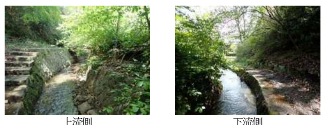
図4 平瀬川初山水路の概況
