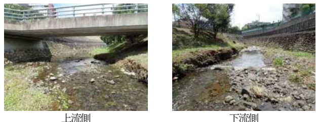
図3 平瀬川支川下長沢橋の概況
