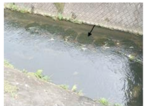
河床に設置されている袋詰根固工
