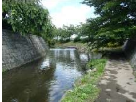
市内の親水整備された水辺の様子（二ヶ領本川・一本込（いっほんいり）橋付近）
