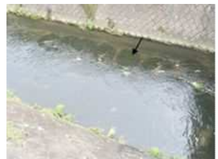
河床に設置されている袋詰根固工
