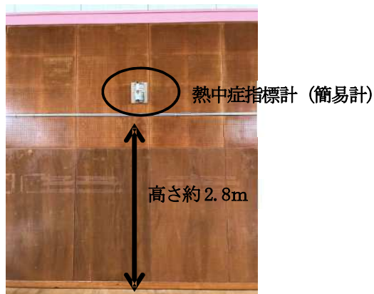
図 13 体育館 1 階南側の壁面に固定した熱中症指標計 (簡易計)
