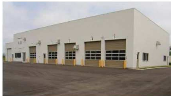
バイオマス混合調整棟外観
