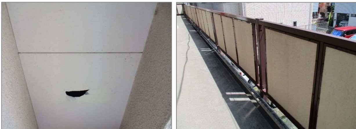
天井面・壁面【ケイ酸カルシウム板第1種・スレートボード】
