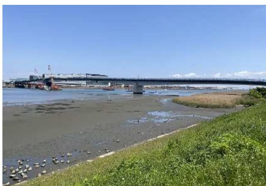
多摩川河口干潟と多摩川スカイブリッジ
