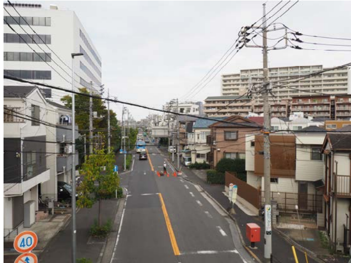
No.5 菰宿歩道橋上から市道菰宿小田中線（Ⅰ）を北北西に望む
