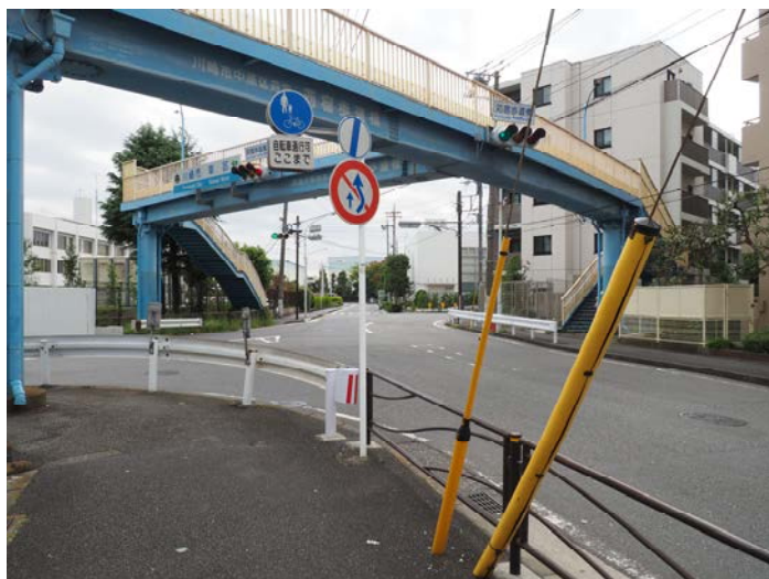
No.4 荻宿歩道橋の状況（荻宿歩道橋交差点）
