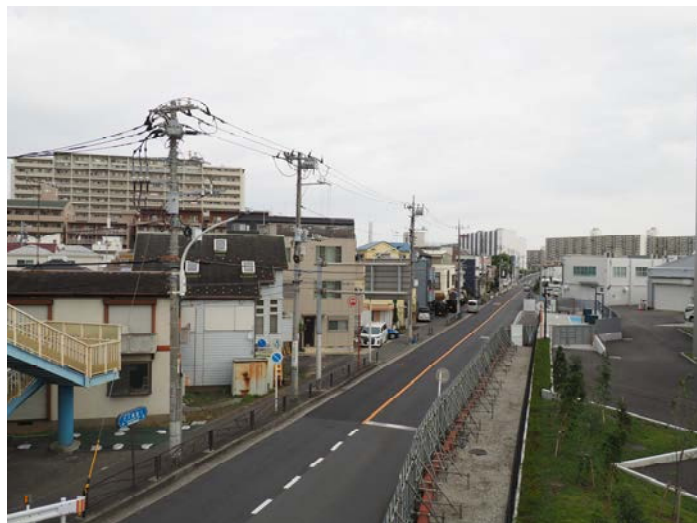
No.7 菰宿歩道橋上から県道大田神奈川線を北東に望む（計画地（K1）方向）
