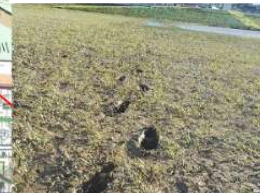
殿町河川敷自由広場（土砂堆積）
