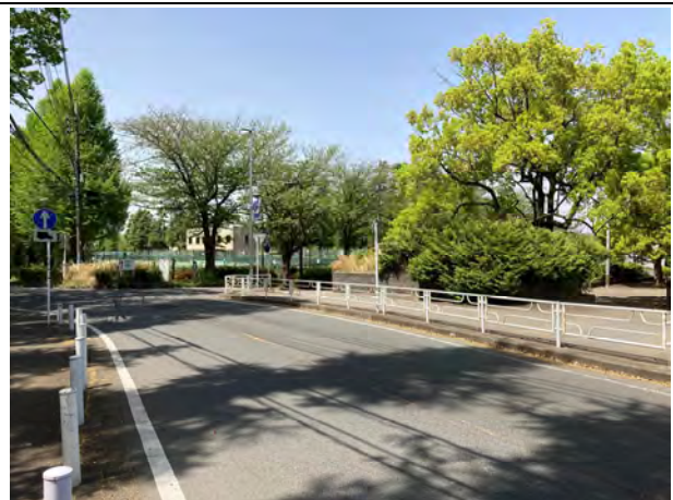
No.6 計画地南側歩道より
