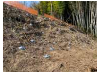
生田榎戸特別緑地保全地区 の斜面安定整備工事
