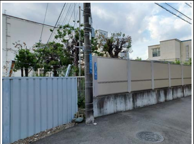
No.6 計画地南東側道路より
