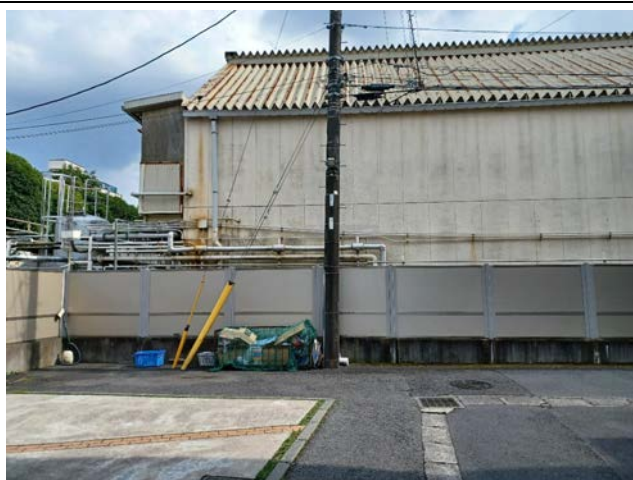
No.3 計画地北東側道路より
