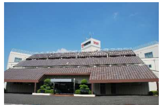
佐倉ソーラーエネルギーセンター（1984年～稼働）
