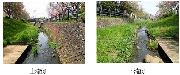
図4 平瀬川柳橋の概況
