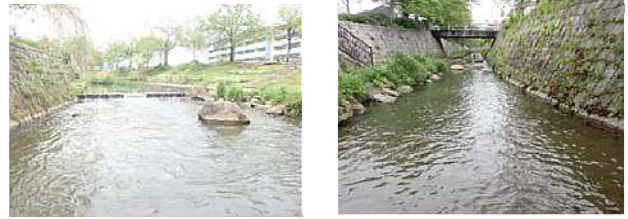
図3 二ヶ領本川一本塚橋の概況
