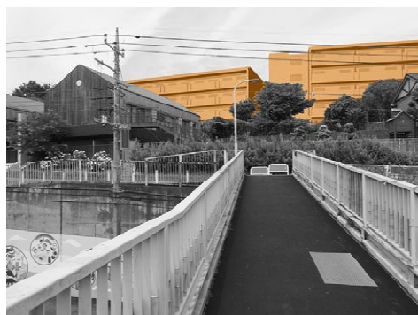
写真 4.6-1(4) 代表的な眺望地点からの景観 (No.4 : 菅生歩道橋)
