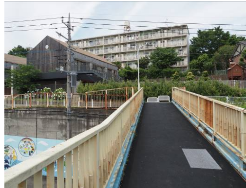
No. 4 菅生歩道橋（計画地東側）
