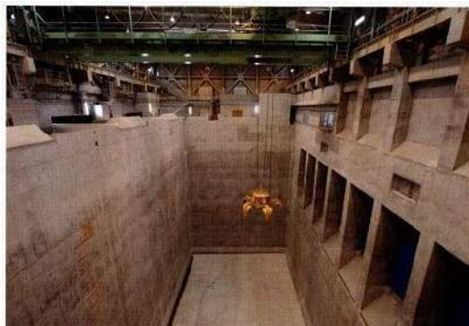
写 1-2 ごみピット内
