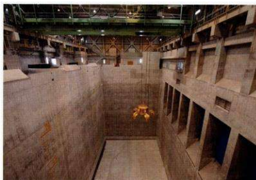
写 1-2 ごみピット内
