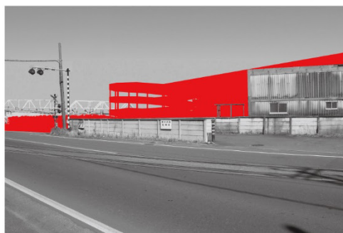
写真 4.7.1-3 代表的な眺望地点からの景観 (No.2 昭和駅前)
