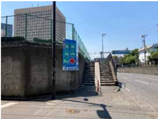
11：国道409号歩道の状況（西を望む）
