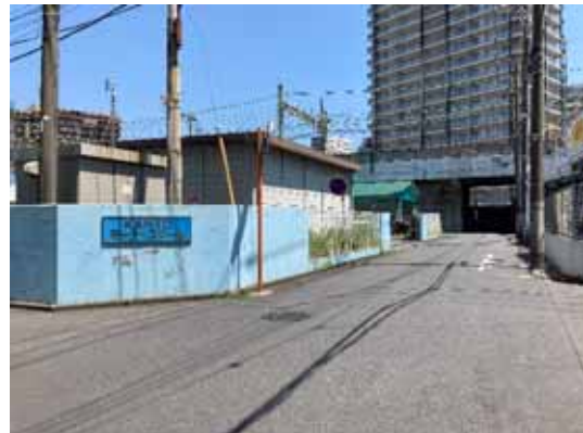
4：駅前本町8号線の状況（西を望む）
