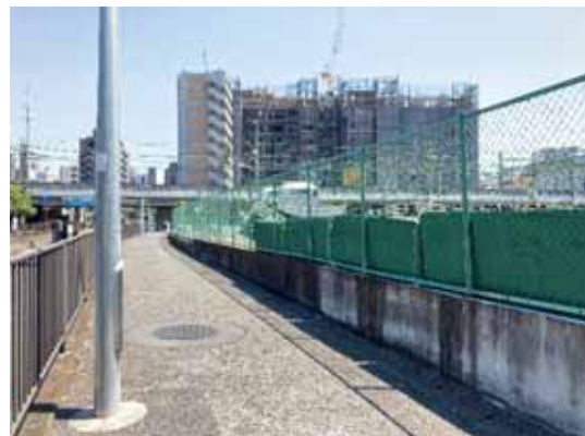
14：国道409号歩道の状況（東を望む）
