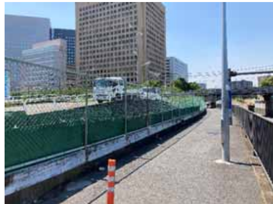
12：国道409号歩道の状況（西を望む）
