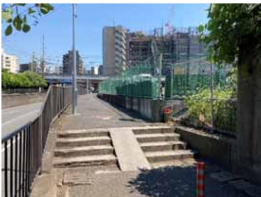
15：国道409号歩道の状況（東を望む）
