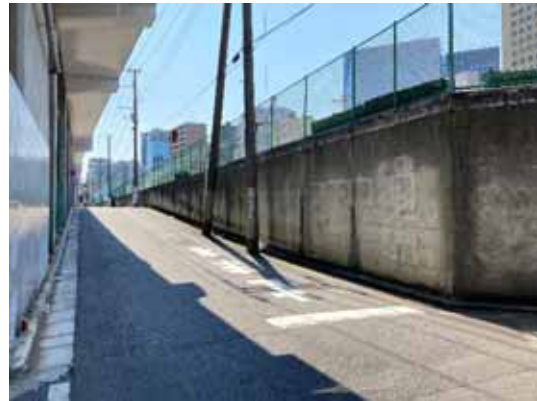
10：駅前本町1号線の状況（南を望む）
