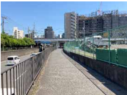
13：国道409号歩道の状況（東を望む）
