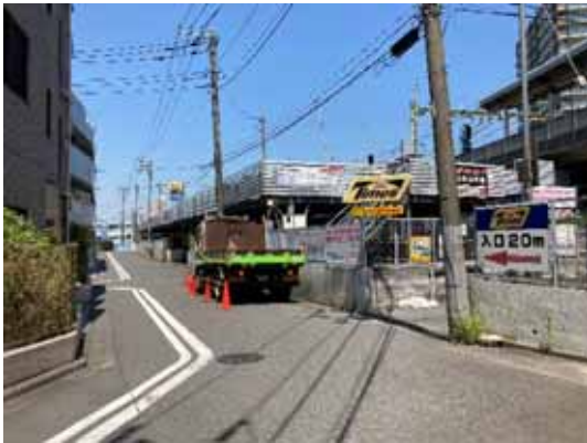
1：駅前本町5号線の状況（北を望む）
