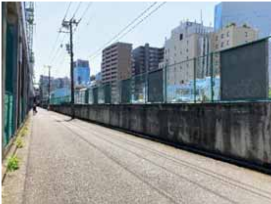
9：駅前本町1号線の状況（南を望む）
