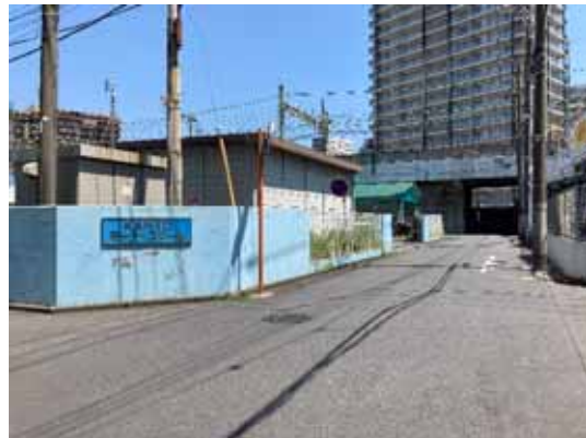
4：駅前本町8号線の状況（西を望む）
