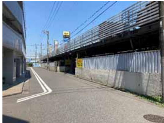
2：駅前本町5号線の状況（北を望む）
