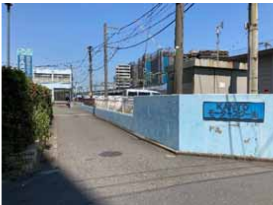
5：駅前本町2号線の状況（北を望む）
