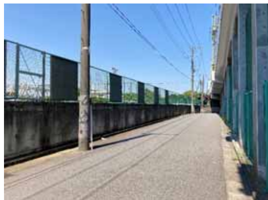
8：駅前本町1号線の状況（北を望む）
