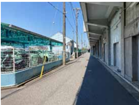
7：駅前本町1号線の状況（北を望む）
