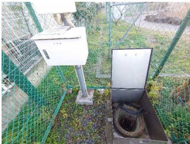
地下水位観測所の水位計
