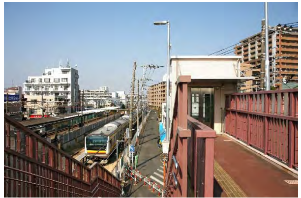
No. 8 宿河原駅付近歩道橋
