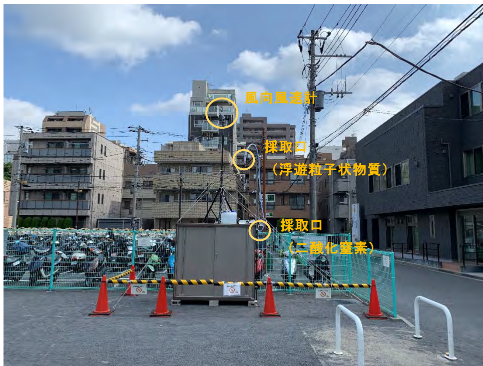
写真 3-1 大気質・気象調査状況（登戸 3 号街区公園）
