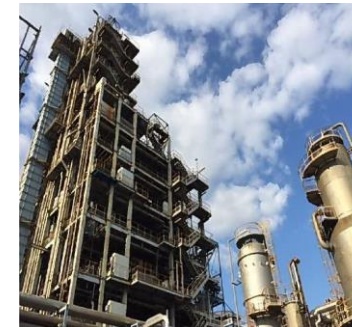
ケミカルリサイクル施設
