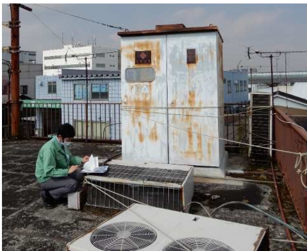
現地確認（掘り起こし調査）
