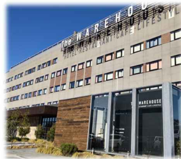
（活用事例） 燃料電池での発電に利用
