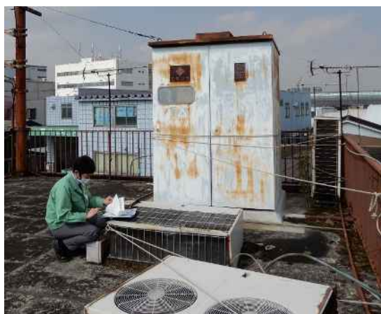
現地確認（掘り起こし調査）
