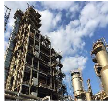
ケミカルリサイクル施設
