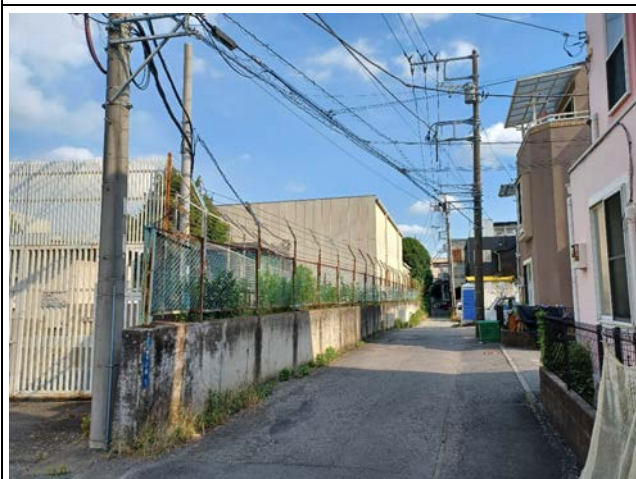
No.11 計画地北西側道路より
