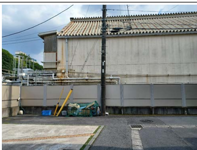
No.3 計画地北東側道路より
