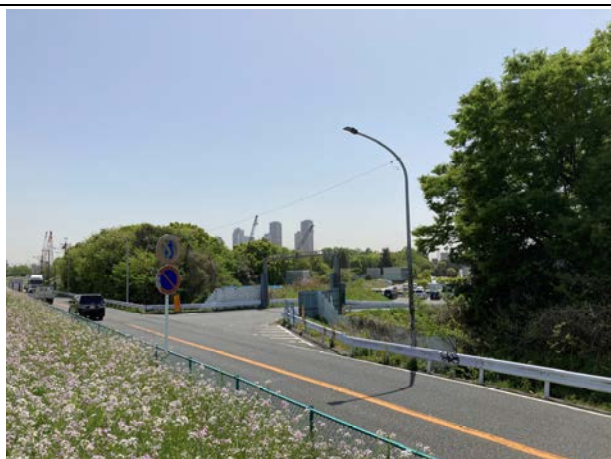
No.1 計画地北西側多摩川沿いより
