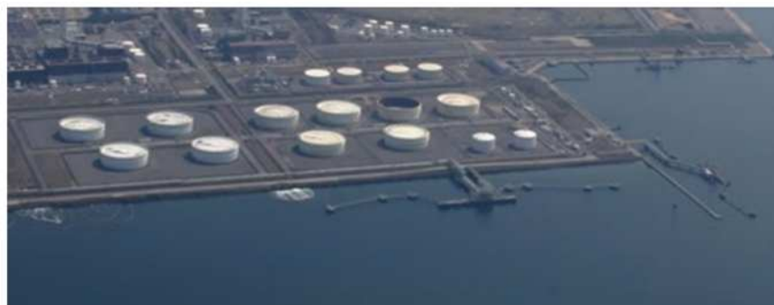
新潟石油共同備蓄基地（東基地）の上空写真
