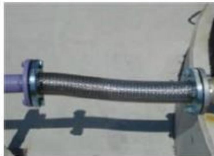
配管の途中に、フレキシブル管等の可とう性配管を入れることにより、地震のゆれによる破断を防止し、配管からの化学物質の漏えいを防止する。
