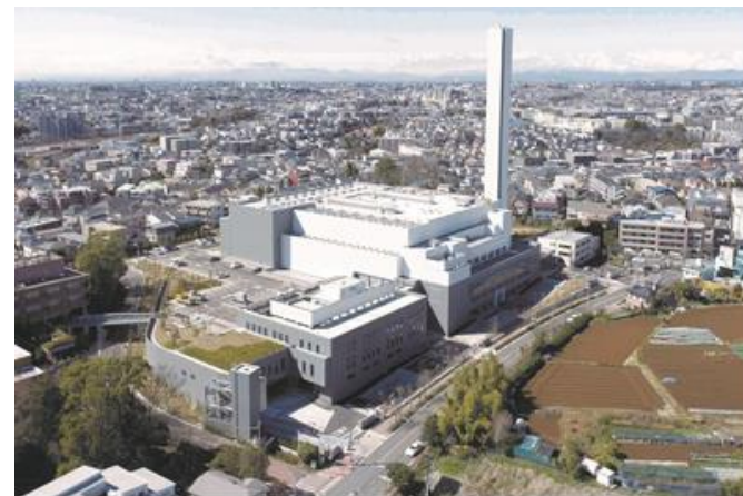
橋処理センター
