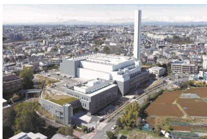
橋処理センター
