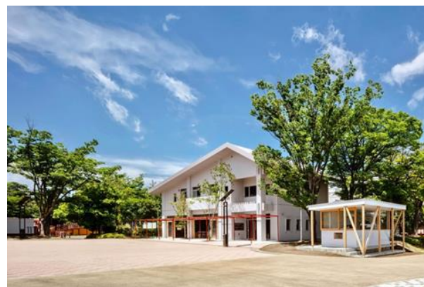
橘公園における飲食等施設の設置
