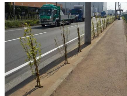
東扇島1号線沿道環境整備工事
