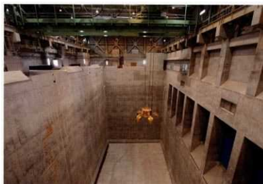
写 1-2 ごみピット内
