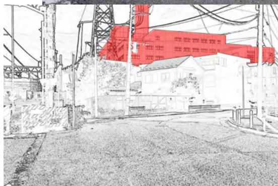
写9.8.1-2(1) 眺望の変化（地点1：矢向踏切付近）
