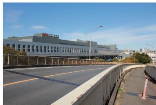
No. 2 川崎港郵便局南東
