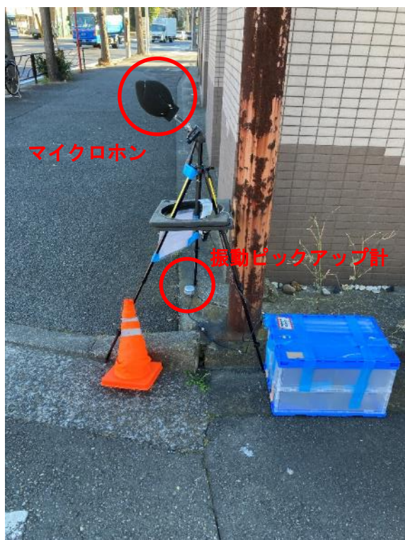
No. 1（県道 101 号扇町川崎停車場線）
