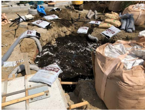
写真 1－3 酸素管の設置 (2021 年 5 月 10 日)
