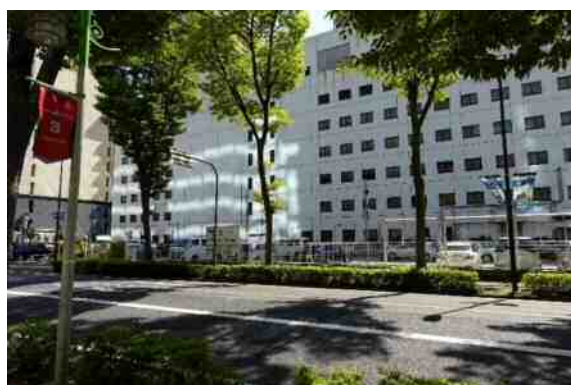
写真 3-1 (4) No. 4 (計画地北西側から南東を望む)
