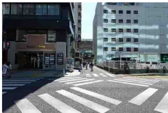
写真 3-1 (2) No. 2 (計画地北東側から南を望む)
