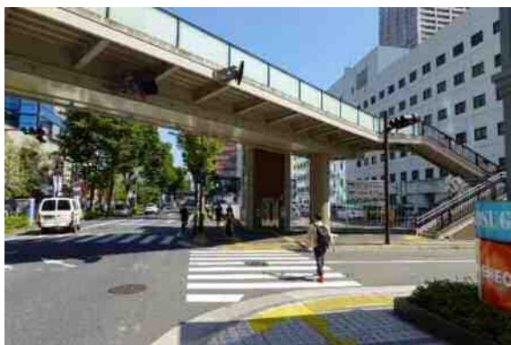
写真 3-1 (5) No. 5 (計画地北西側から南東を望む)
