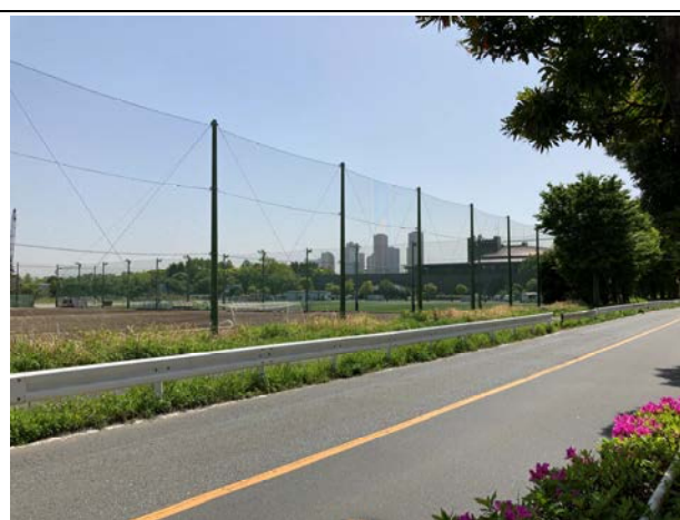
No.10 計画地北西側歩道より
