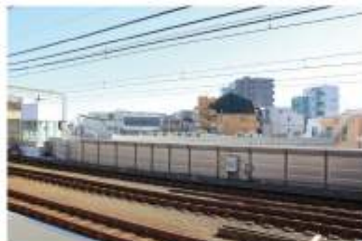
No. 2 高津駅構内
