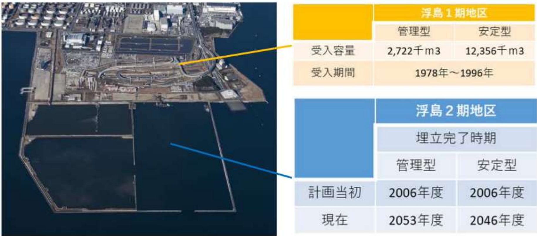
図 浮島地区における埋立状況
