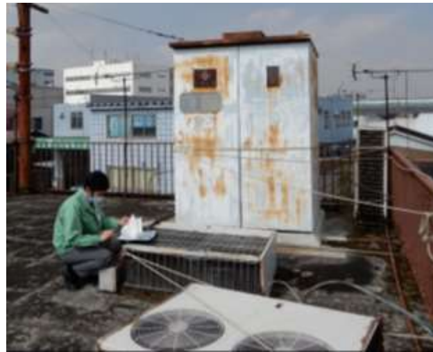
現地確認（掘り起こし調査）
