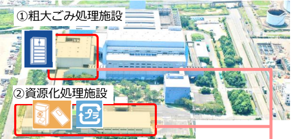
＜浮島処理センター敷地＞
