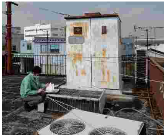
現地確認（掘り起こし調査）
