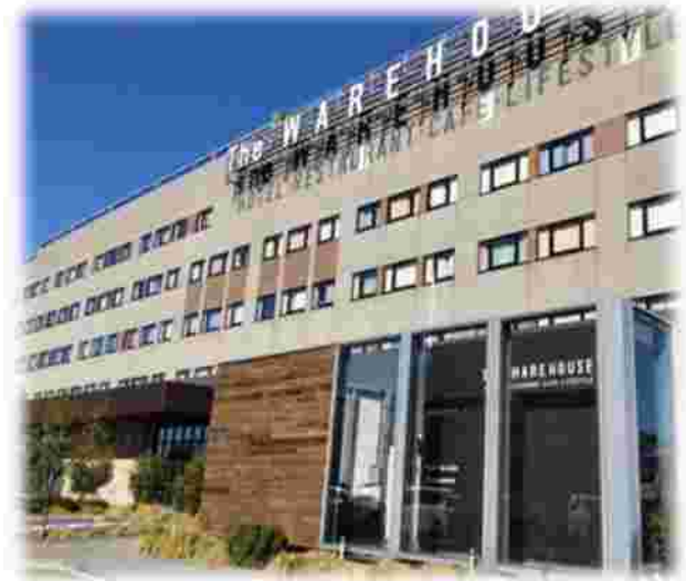
（活用事例） 燃料電池での発電に利用
