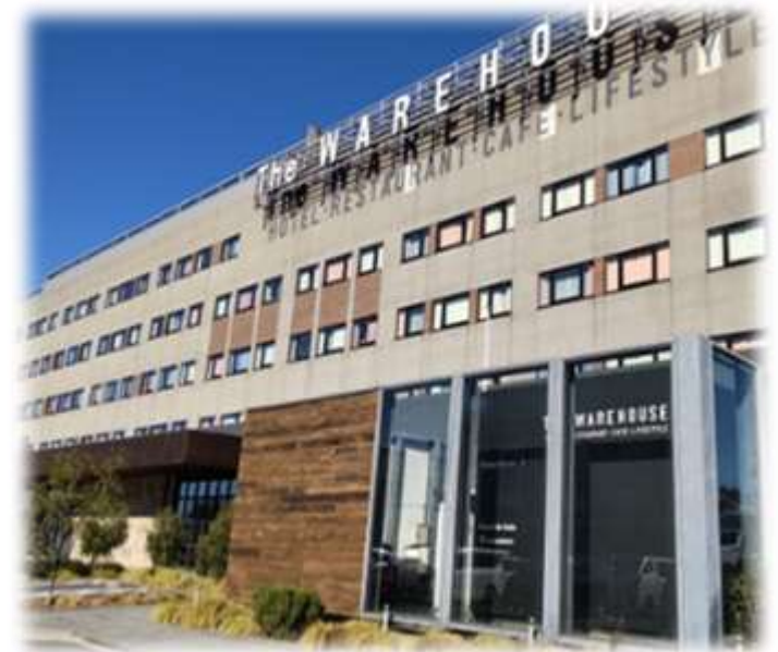
（活用事例） 燃料電池での発電に利用
